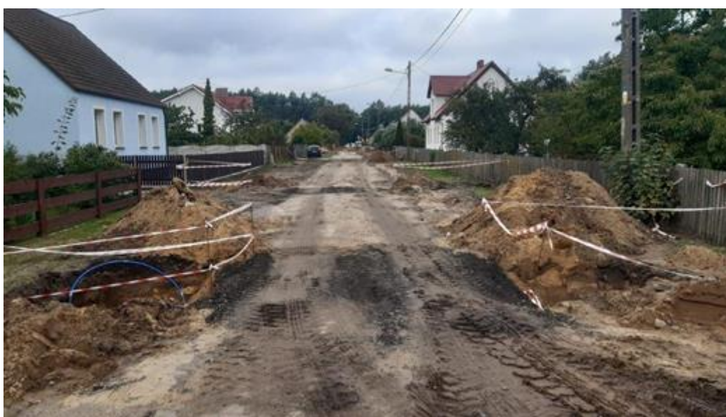
Zdjęcie nr 3 Przebudowa dróg powiatowych 1418F w ciągu ul. Leśnej
