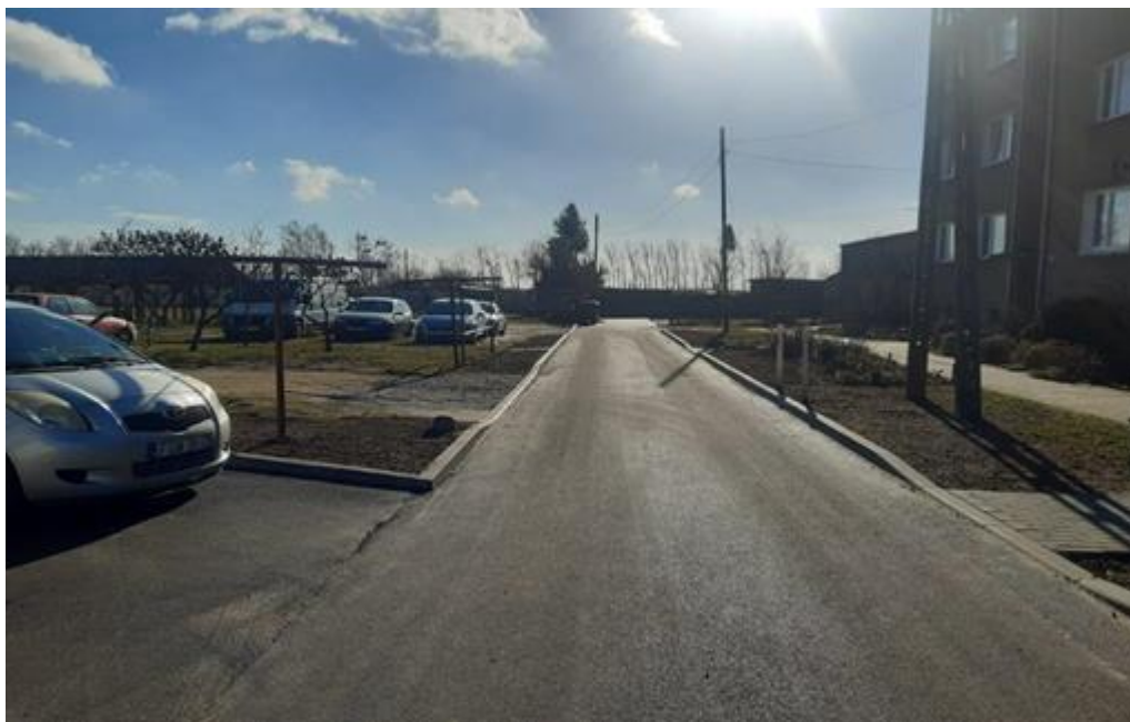
Zdjęcie nr 6 Remonty odcinków dróg przy ul. Osiedlowej w Baczyńie
