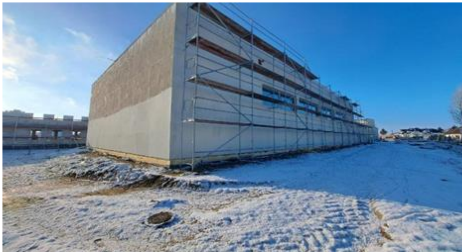
Zdjęcie 16 Budowa sali gimnastycznej przy szkole podstawowej w Baczynie
