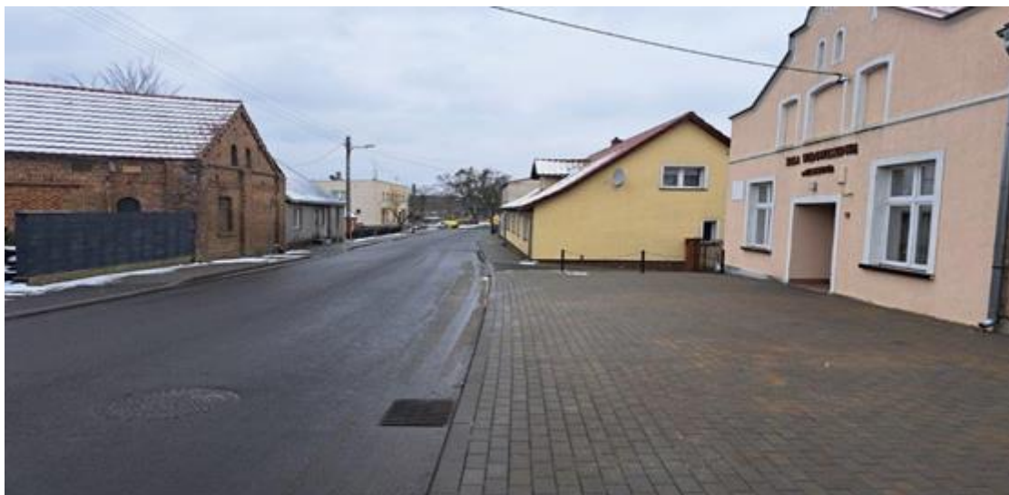
Zdjęcie nr 4 Przebudowa dróg powiatowych 1419F w ciągu ul. Myśliborska
