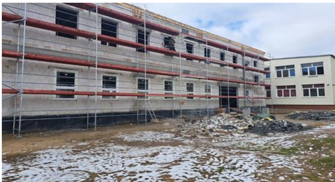
Zdjęcie 18 Rozbudowa szkoły podstawowej w Baczynie
