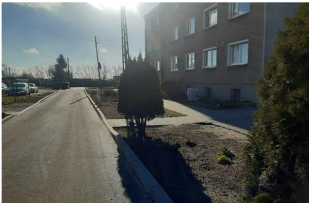
Zdjęcie nr 5 Remonty odcinków dróg przy ul. Osiedlowej w Baczynie
