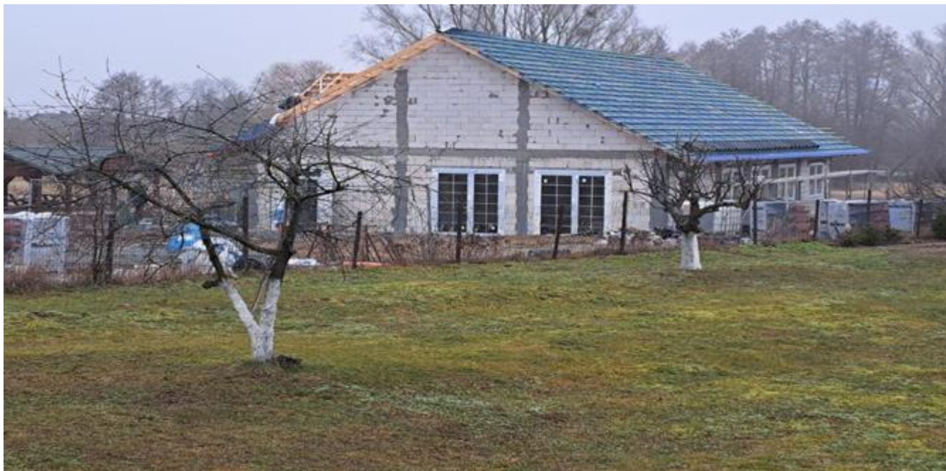
Zdjęcie nr 23 Budowa sali wiejska w Marwicach
