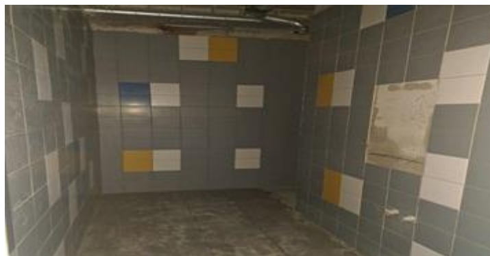
Zdjęcie 17 Budowa sali gimnastycznej przy szkole podstawowej w Baczynie (pomieszczenie łazienki)
