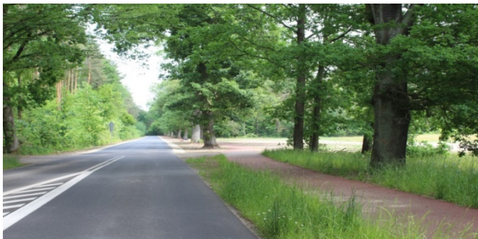
Zdjęcie nr 4 droga nr 1420F Wysoka-Ściechów, odcinek 2
