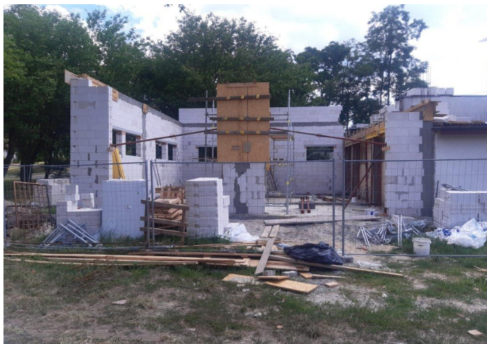
Zdjęcie nr 18 Rozbudowa OSP Lubno
