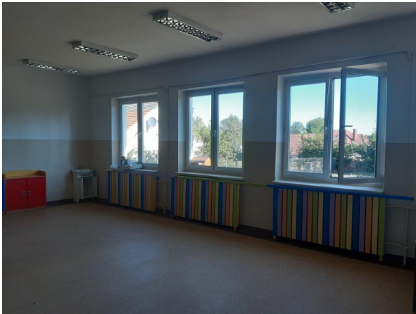
Zdjęcie nr 20 Remont szkoły podstawowej w Stawie
