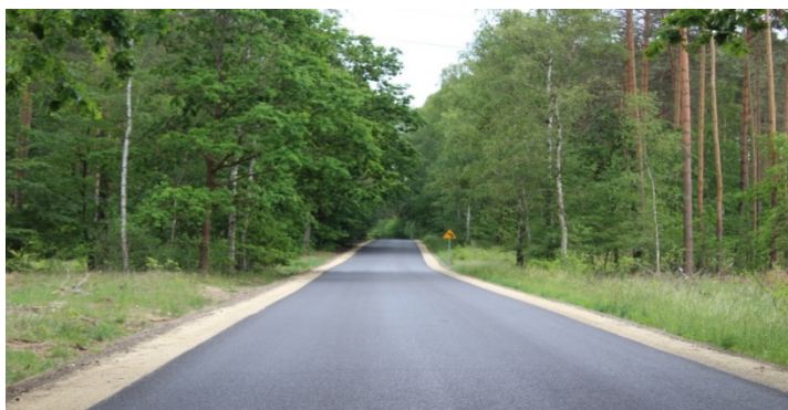
Zdjęcie nr 3 droga nr 1420F Wysoka-Ściechów, odcinek 2
