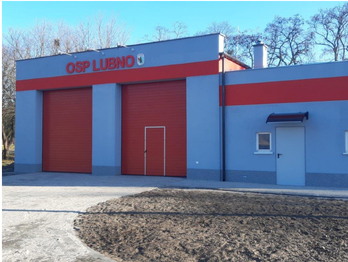
Zdjęcie nr 19 Rozbudowa OSP Lubno
