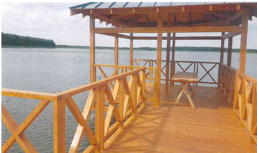
Pomost nad jeziorem Marwicko, zdjęcie nr 2
