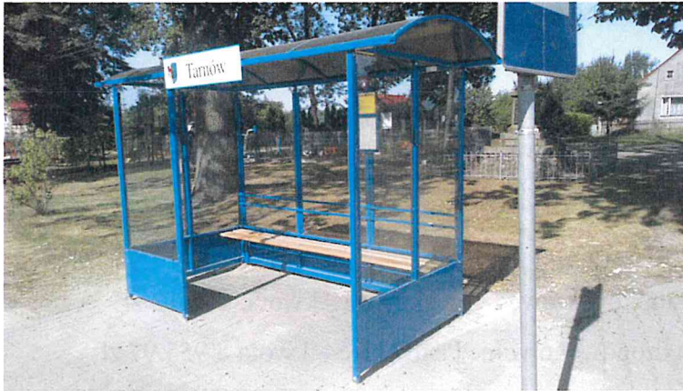
Wiata przystankowa Tarnów, przy drodze wojewódzkiej 130
