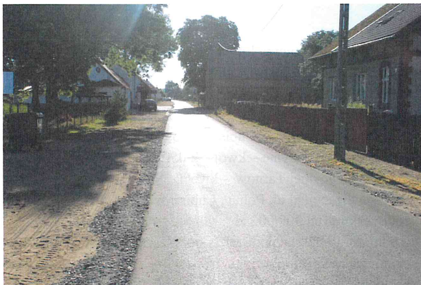
Sanitex Sp. z o.o. – Budowa kanalizacji ściekowej wraz z przepompowniami oraz odcinkami przyłączy w m. Wysoka – nakładka asfaltowa
