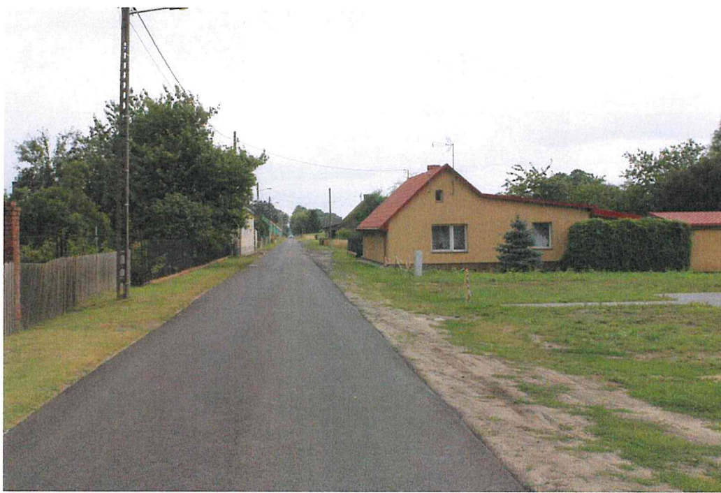
Nakładka asfaltowa na drodze powiatowej w Ściechowie
