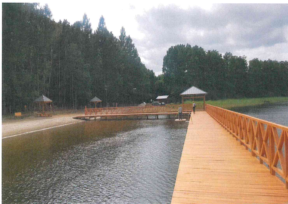
Pomost nad jeziorem Marwicko, zdjęcie nr 1
