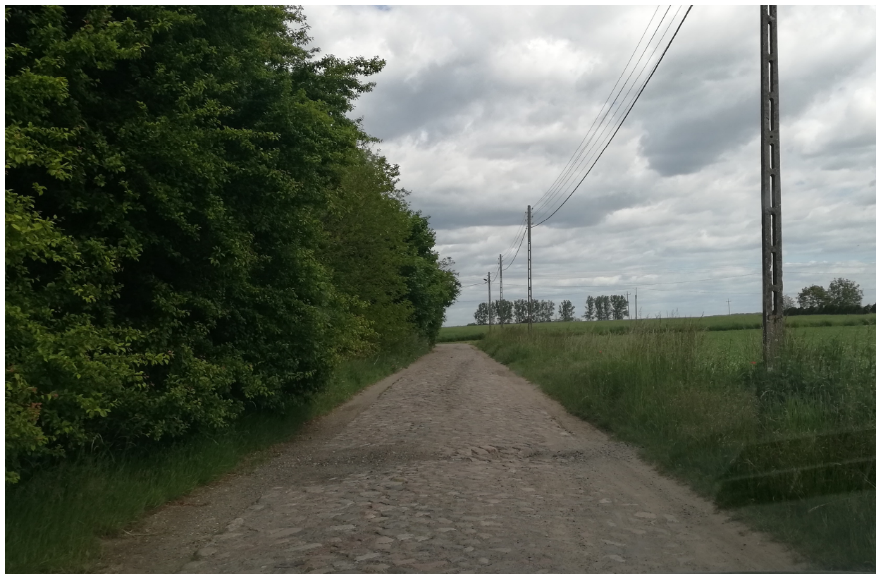
Istniejąca droga o nawierzchni z brukowca
